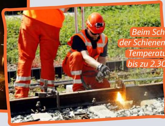
Beim Schweißen der Schienen entstehen Temperaturen von bis zu 2.300 Grad.
